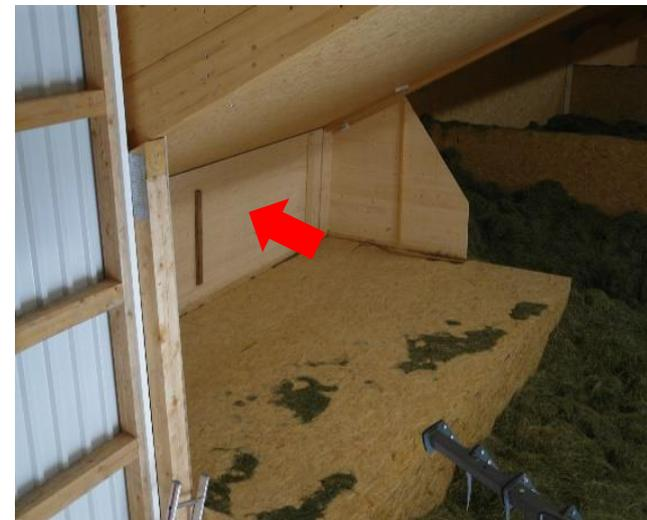
Umschaltklappe über Lüfterkammer
