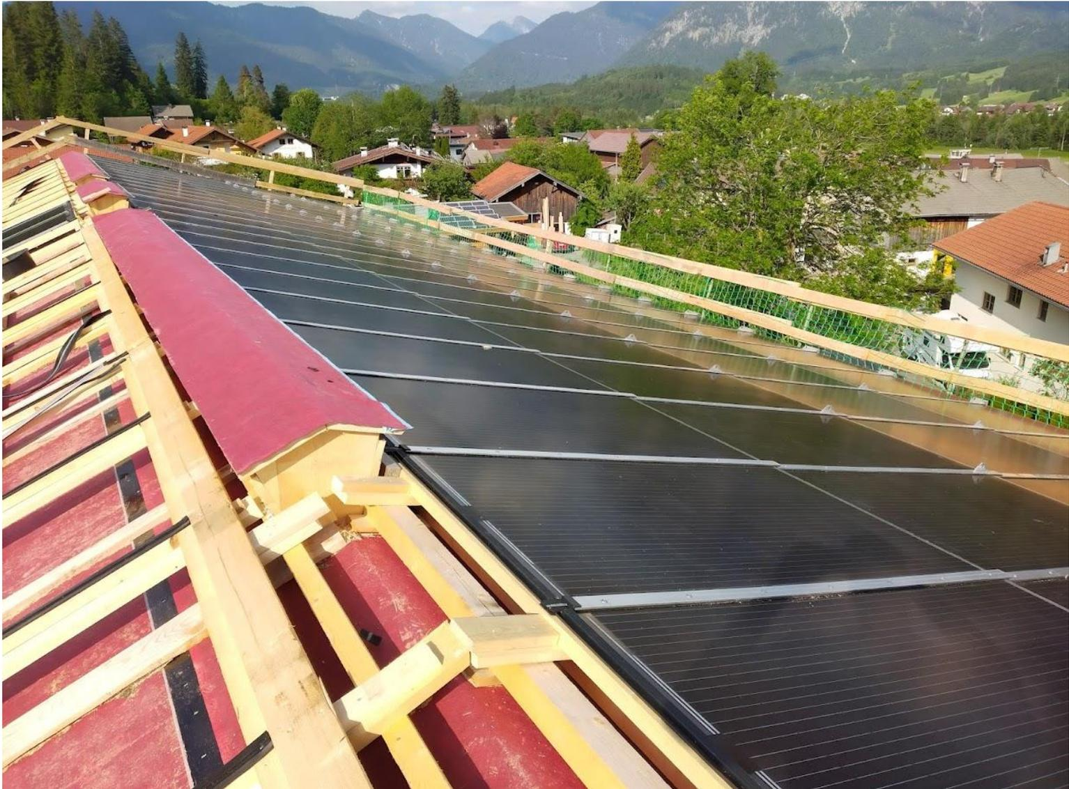
Dachabsaugung unterhalb von regendichten, leicht überlappenden PV-Modulen im Bau
