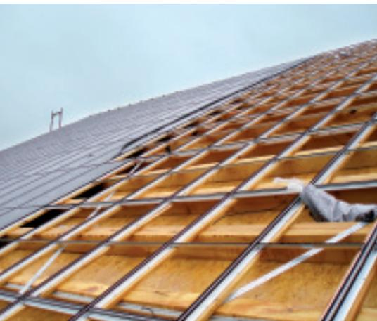
◀ Eine interessante Lösung ist die Kombination von Fotovoltaik mit einer Dachwärmenutzung.
