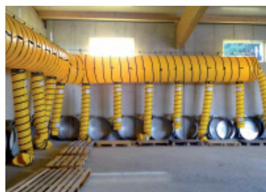
Die Trocknungsluft kann statt über einen betonierten Bodenkanal oder über Kanäle aus Holz oder Blech auch mittels flexibler Polyamid-Schläuchen und Stahlblechzwischenringen zugeführt werden.
