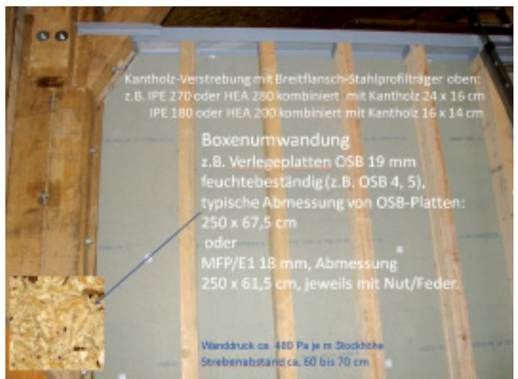
Abb. 4: Optimale Boxendimensionierung
